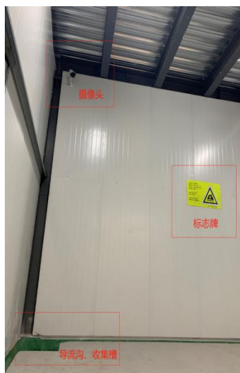
危废仓库内部
