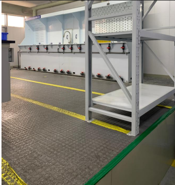
酸洗、氧化等槽体均架空设置
