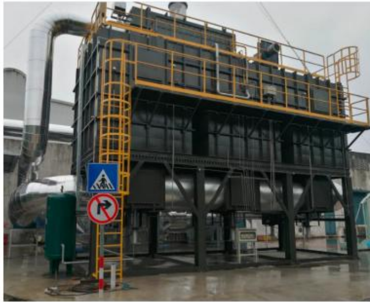
图 7-7 三床 RTO 工程照片
