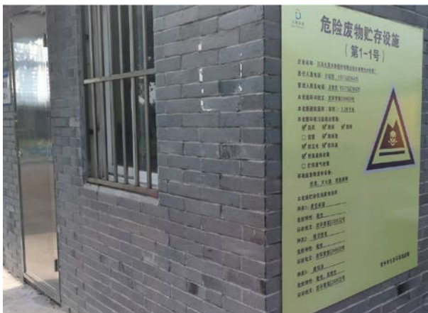
危废仓库外部：
